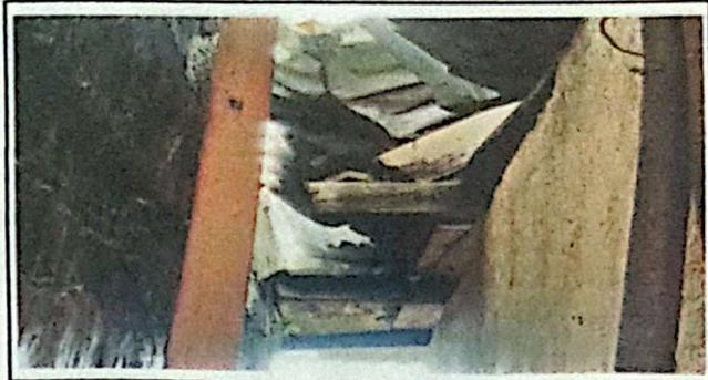
Foto 2: La madera que sostiene el techo esta en malas condiciones.
