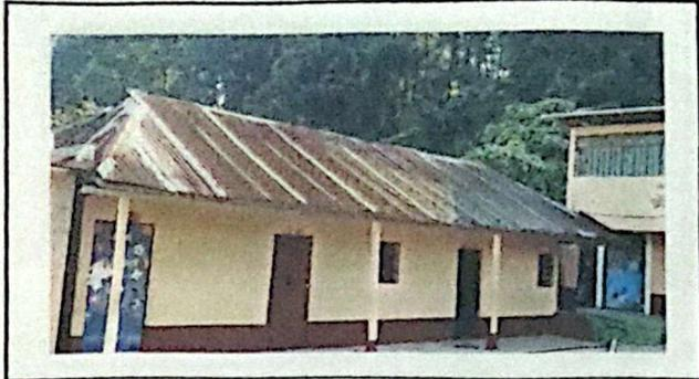
Foto 1: Laminas deterioradas
